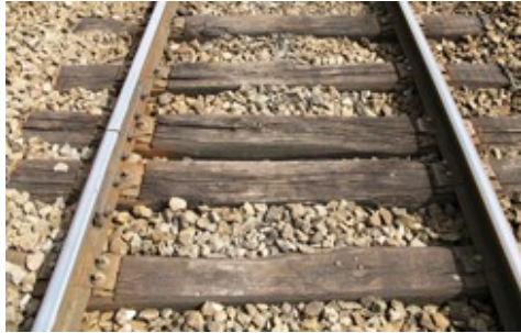
Rails courts sur traverses bois
