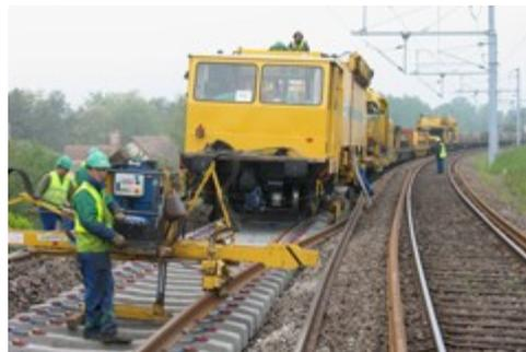
*Longs Rails soudés sur traverses béton*
