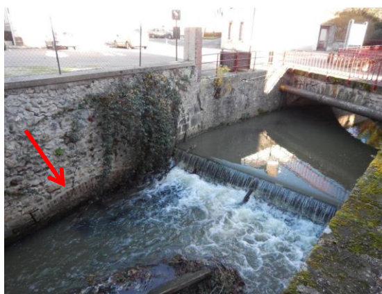
Fig. 18. Vue du seuil et traces de l'ancien bief souterrain
