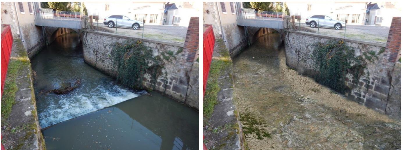
Fig. 51. Photomontage Avant/Après sur l'ouvrage de la mairie (OH6.3)
