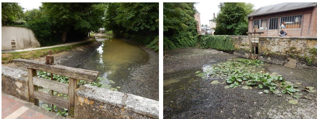
Fig. 4. Vue de la vanne motrice, du plan d'eau amont et du lavoir
