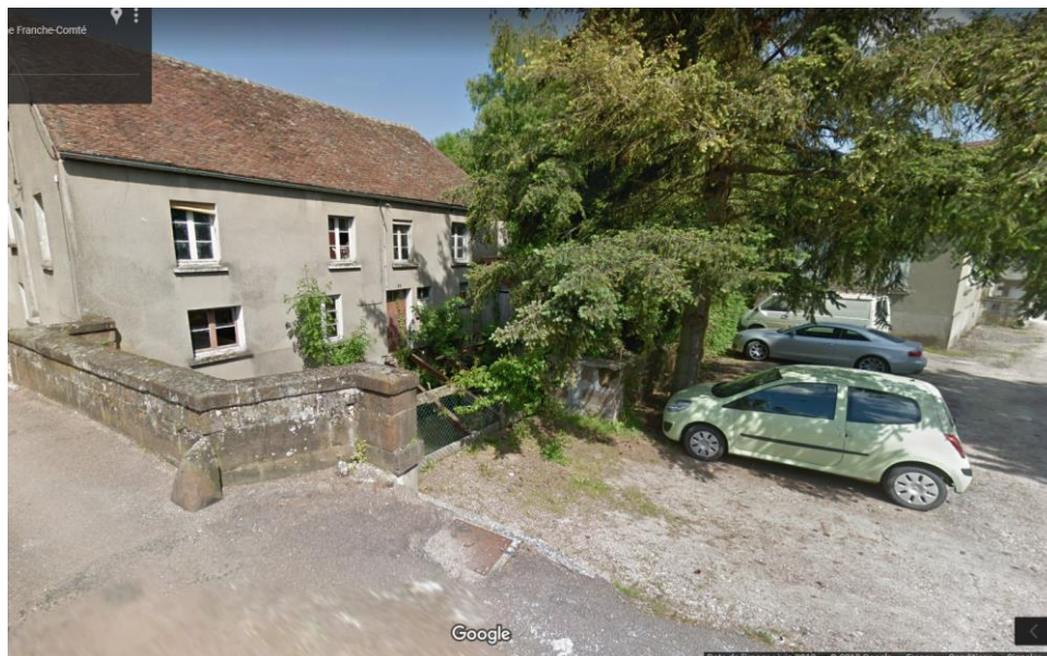
Fig. 23. Vue de l'amont du tronçon 2, datant de juin 2013
