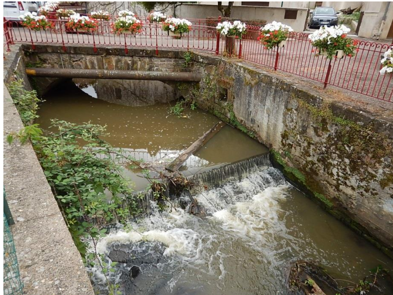
Fig. 5. Seuil fixe 6.3 vue de l'aval
