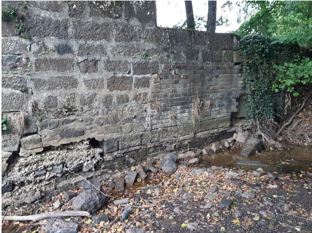
Fig. 28. Vues de l'état actuel de l'ouvrage du Moulin de l'Arche
