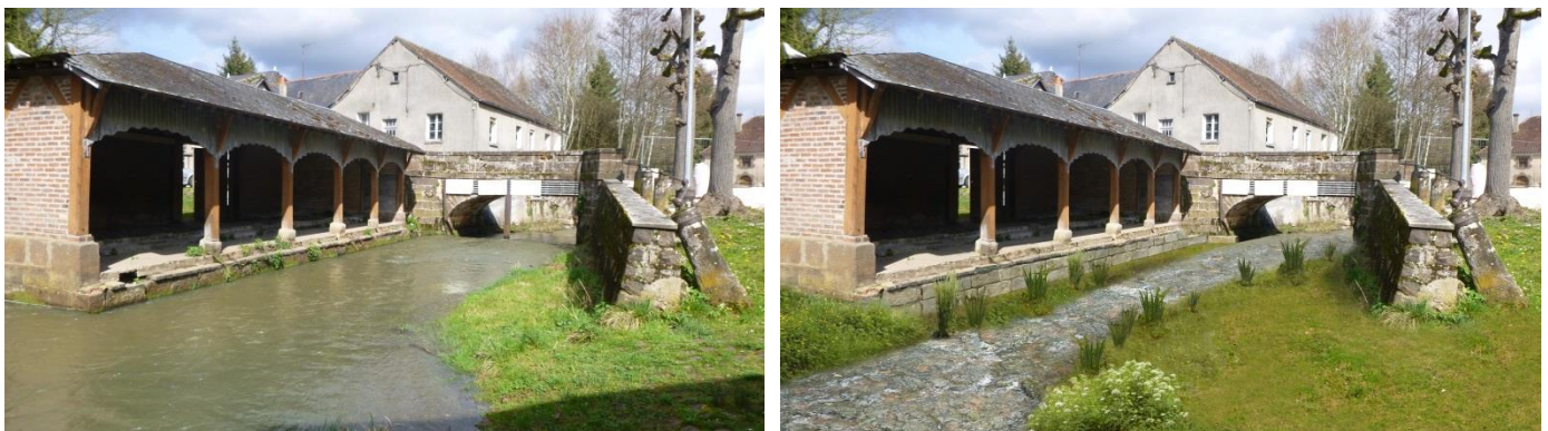
Fig. 52. Photomontage Avant/Après sur l'ouvrage du lavoir (OH 6.4)*
