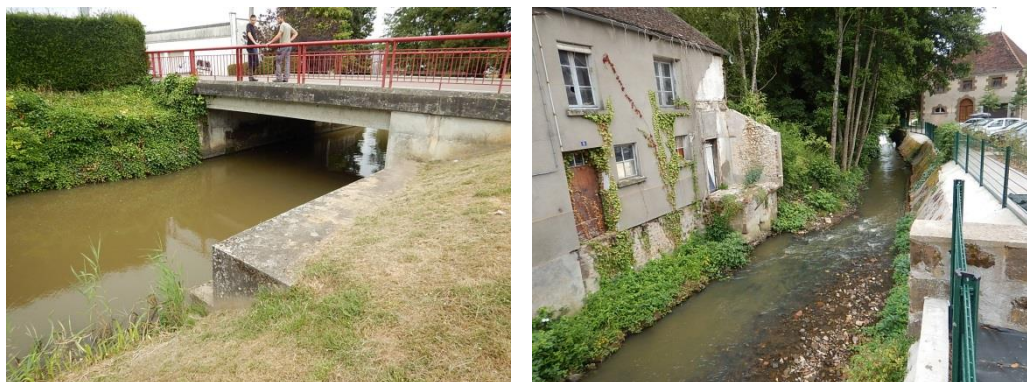
Fig. 36. Pont en amont direct du moulin de l'Arche, et bâtiments situés environ 200 en amont
