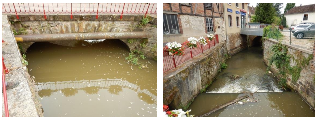
Fig. 7. Vue amont et aval de l'ouvrage 6.3
