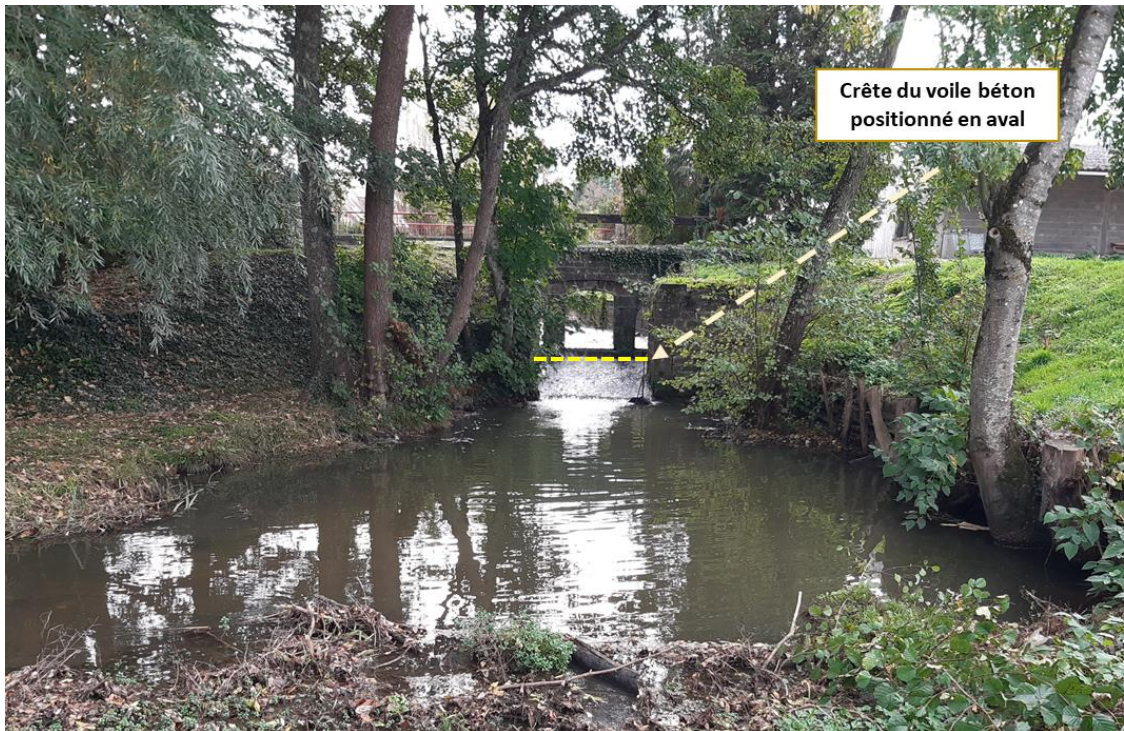
Fig. 29. Vue aval du coursier et calage altimétrique du voile aval
