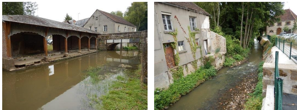
Fig. 10. Vue amont (à gauche) et aval (à droite)
