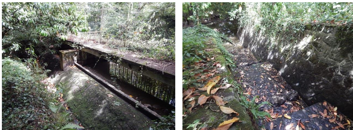
Fig. 3. Vue du déversoir et du canal de décharge associé
