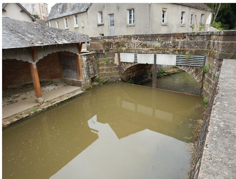
Fig. 8. Seuil mobile - vue de l'aval
